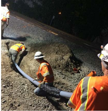
Installing Conduit
