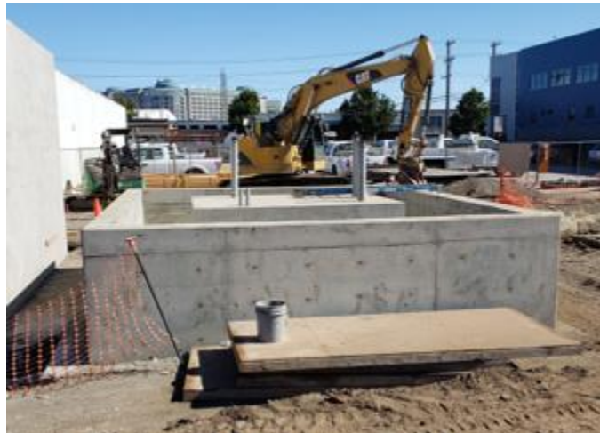
PS-3 – Pouring Transformer pad
